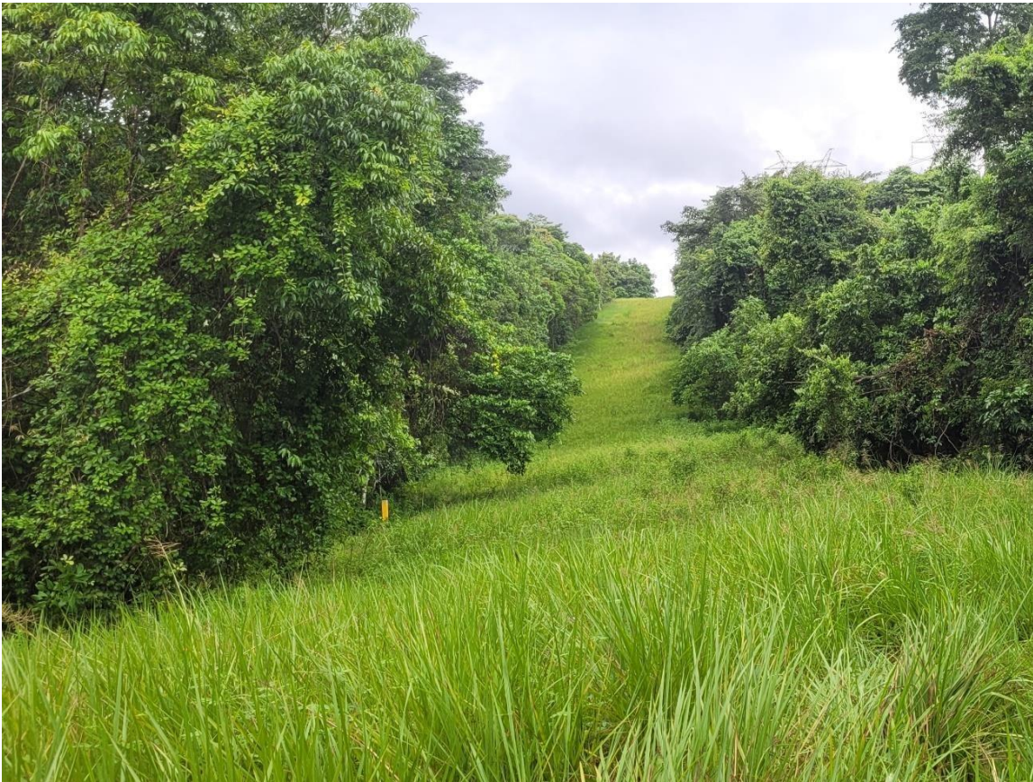
Figura 2 – Área impactada pela presença de uma faixa de dutos na Reserva Biológica União, Rio de Janeiro. Os dutos estão enterrados e há a remoção periódica da vegetação nesta faixa. Fonte: Juan David Rojas Arias.
